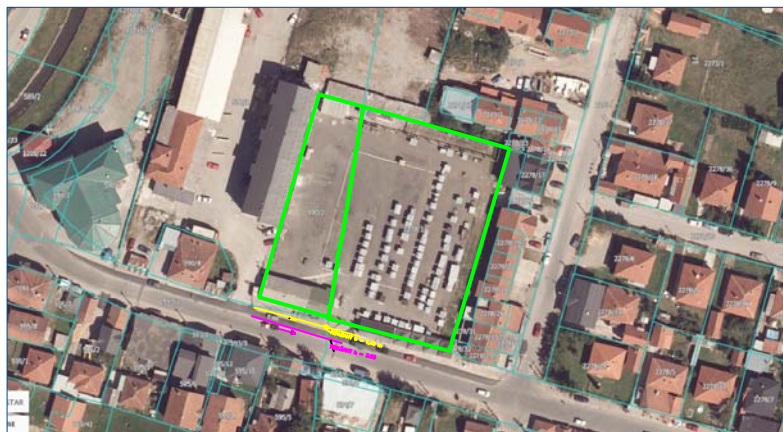
ORTOFOTO SNIMAK LOKACIJE SA MONTAŽNIM OBJEKTIMA-TEZGAMA PLANIRANIM ZA UKLANJANJE
